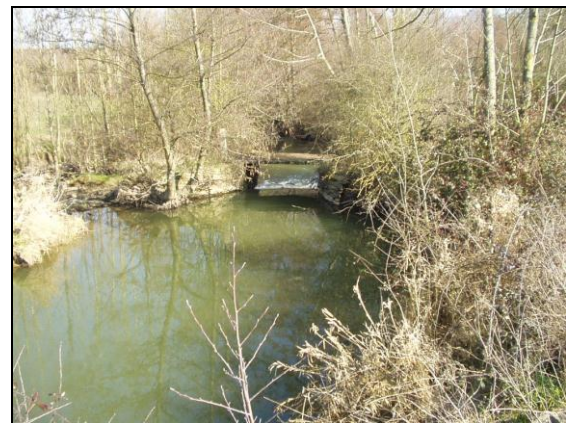
Ancien batardeau et bras de décharge
