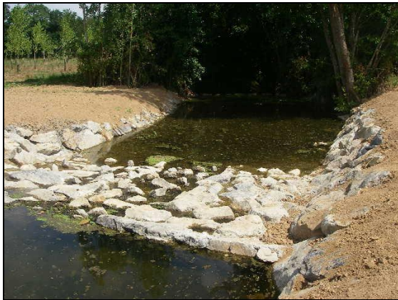
Rampe et mini-seuil en aval en 2010
