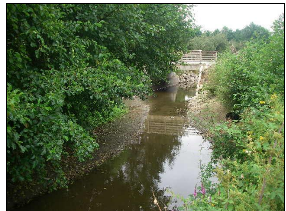
Vue amont pont 2010
